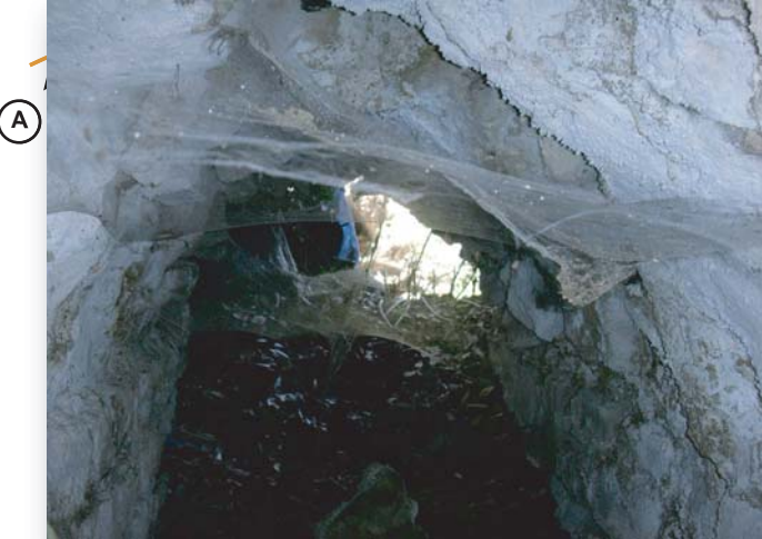
Spécus aval sur le plan de rupture
