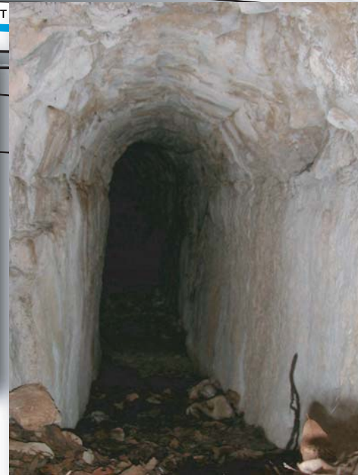
Canal romain (spécus) 1,45 x 0,68 en bon état, légères concrétions
