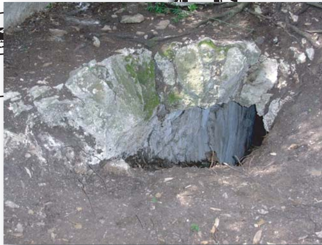
Affleurement de la voûte du canal romain visitable
