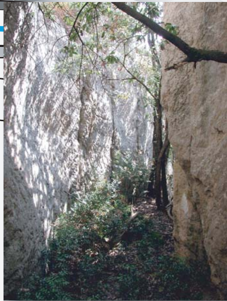
Tranchée à l'aval de l'effondrement
