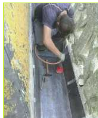
Réfection des chéneaux
