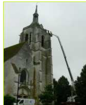
Nacelle installée pour l'approvisionnement des matériaux
