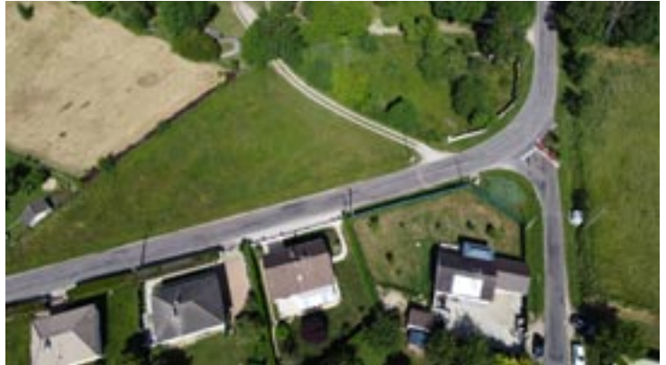
Croisement route de la Brumance et route de la tuilerie Bas-Turny
